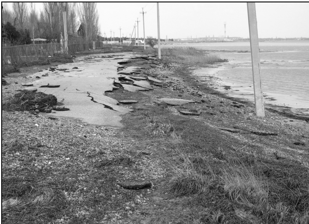
Мал.1. Абразійно небезпечна ділянка Джарилгацької затоки в межах східної частини смт Лазурне, зруйнована внаслідок штормового нагону дорогах.
